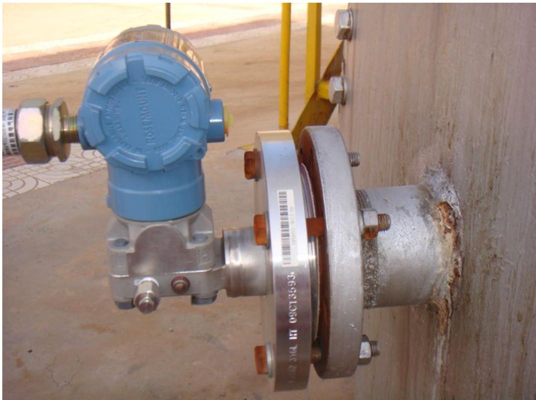
普通静压式液位计测量膜片在罐体法兰连接处，需做保温处理，测量膜片处易堵塞，易粘附杂质。
