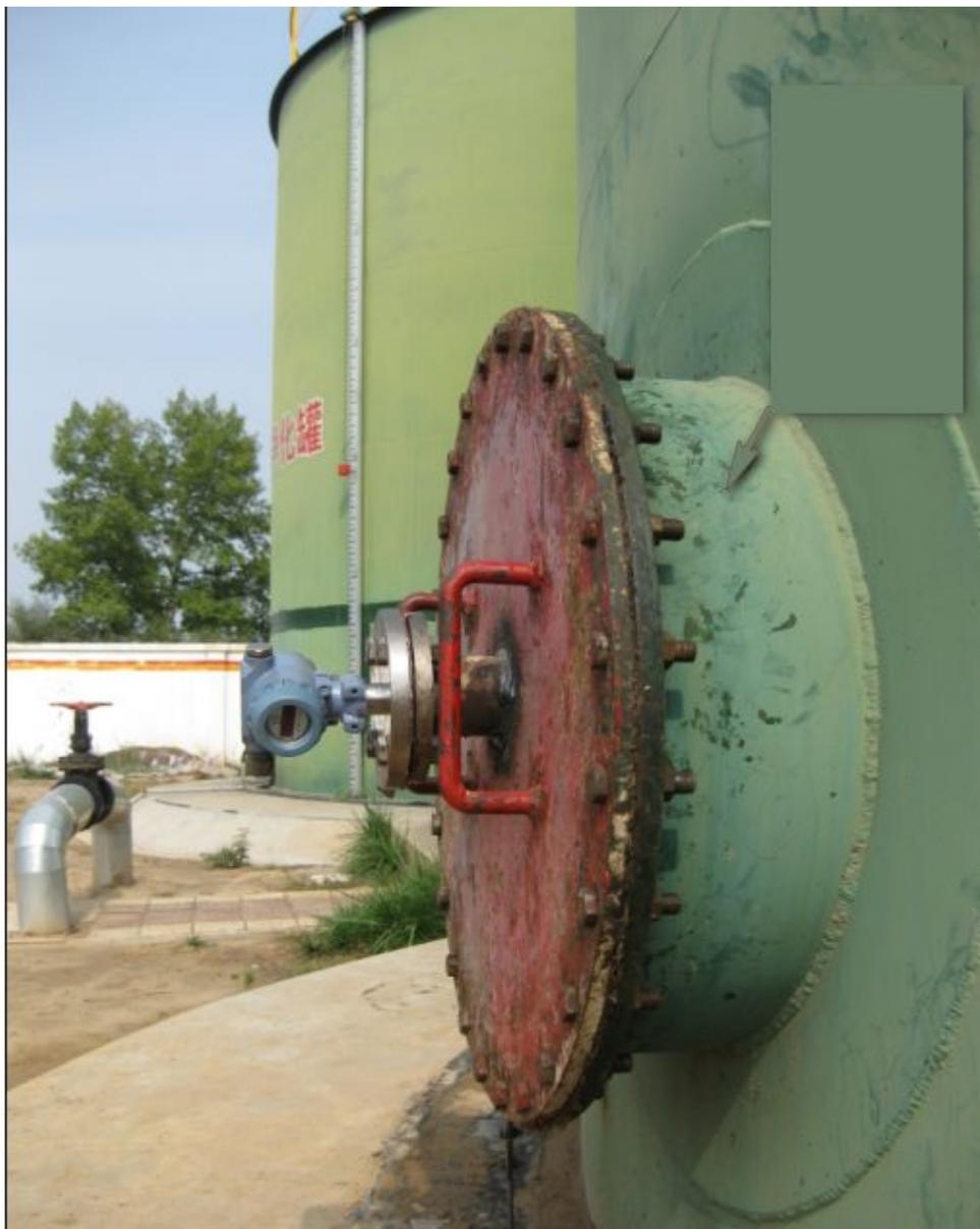
采用插入式方式安装在罐体底部，重量轻无需安装支架，传感器测量膜片深入罐体中，无需保温伴热，传感器膜片不易堵塞也不易冻坏。
